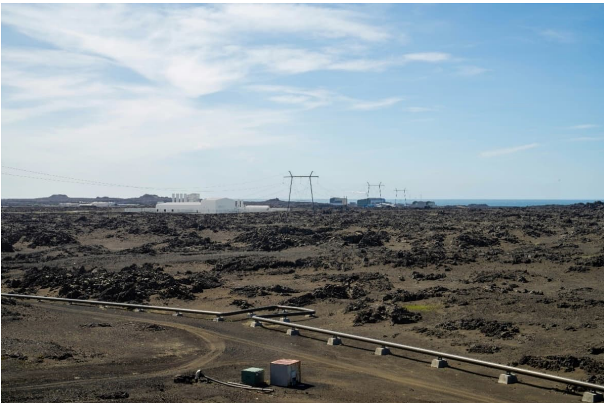
Mynd 10.15 Staður D. Horft í átt að verksmiðju frá mótum lagnaleiðar og gönguleiðar (100 gíga leiðin).
