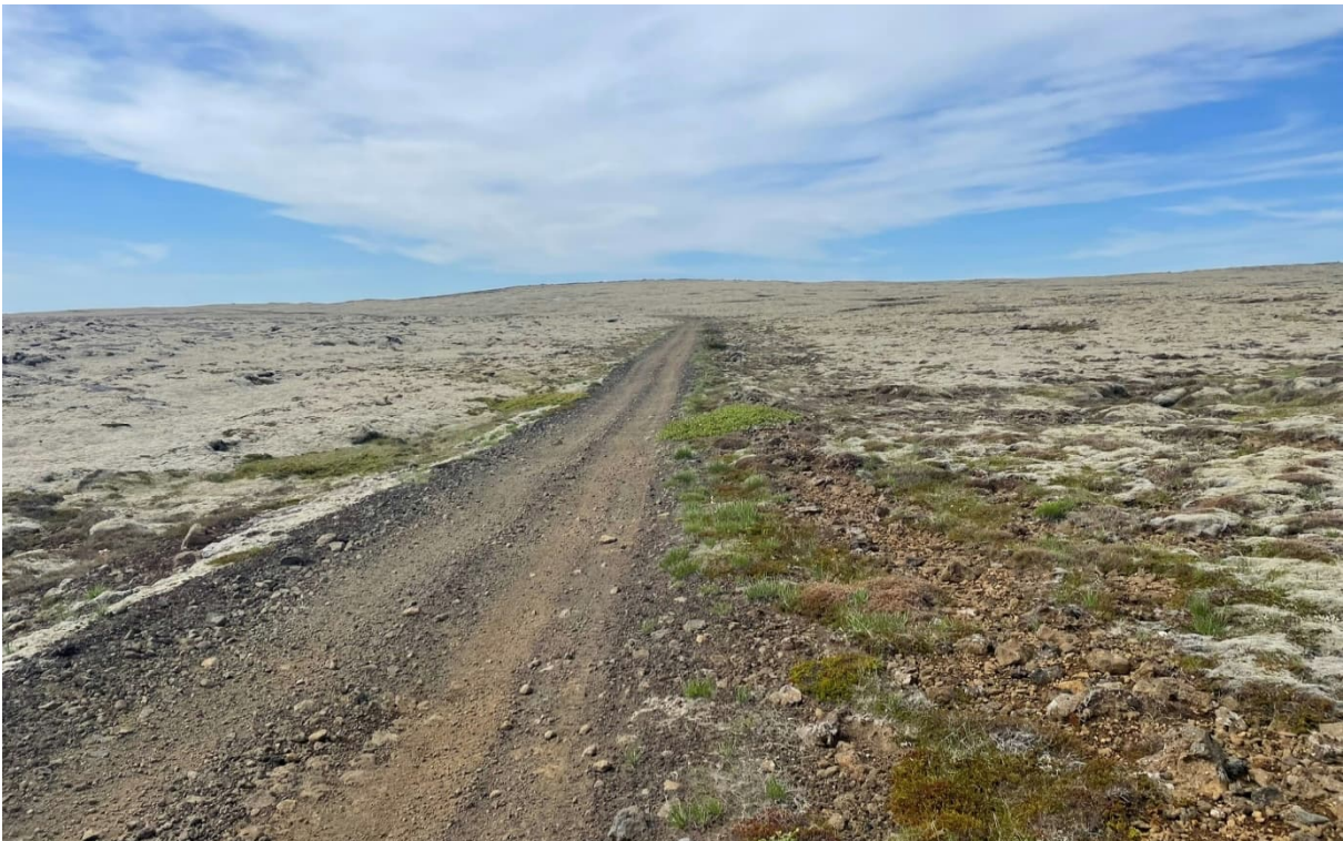
Mynd 4.9 Þjónustuvegur milli Svartsengis og Reykjanesvirkjunar þar sem fyrirhuguð lögn verður lögð. Horft til vesturs. Ljósmyndastaður 2.
