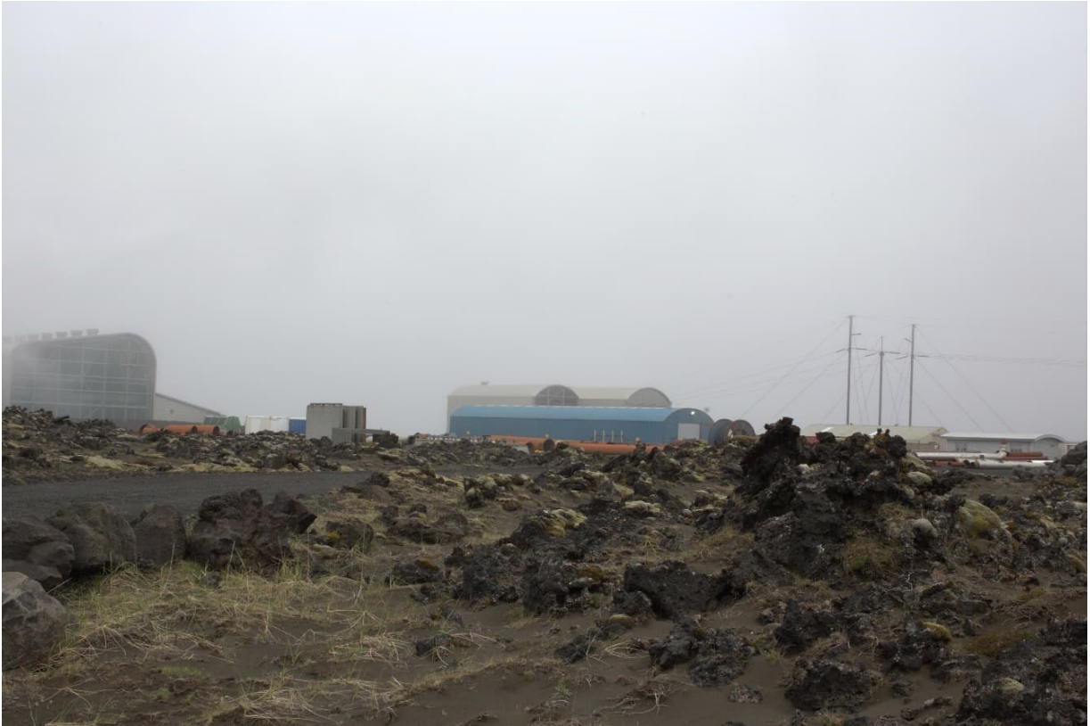
Mynd 4.3 Mynd tekin frá fyrirhugaðri lóð í átt að Reykjanesvirkjun.
